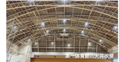
第一体育館の天井改修
